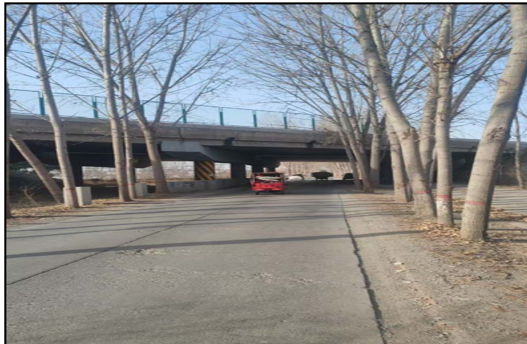
K1+500 处下穿晋新高速公路现状
